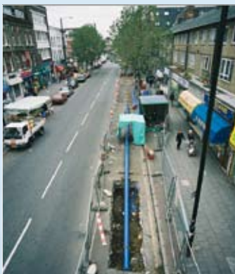
Takto zpravidla probíhá výměna vodovodních trubek
