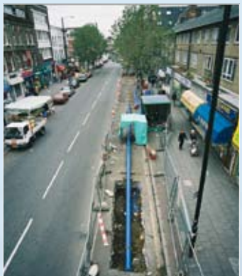
Typischer Austausch eines Wasserrohres
