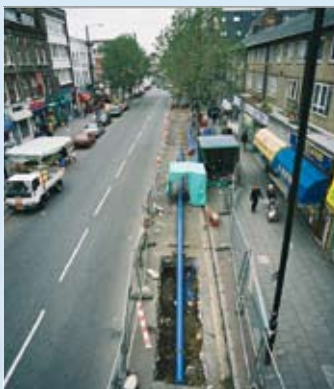
Mar a chuirtear príomhphíobán uisce nua isteach de ghnáth
